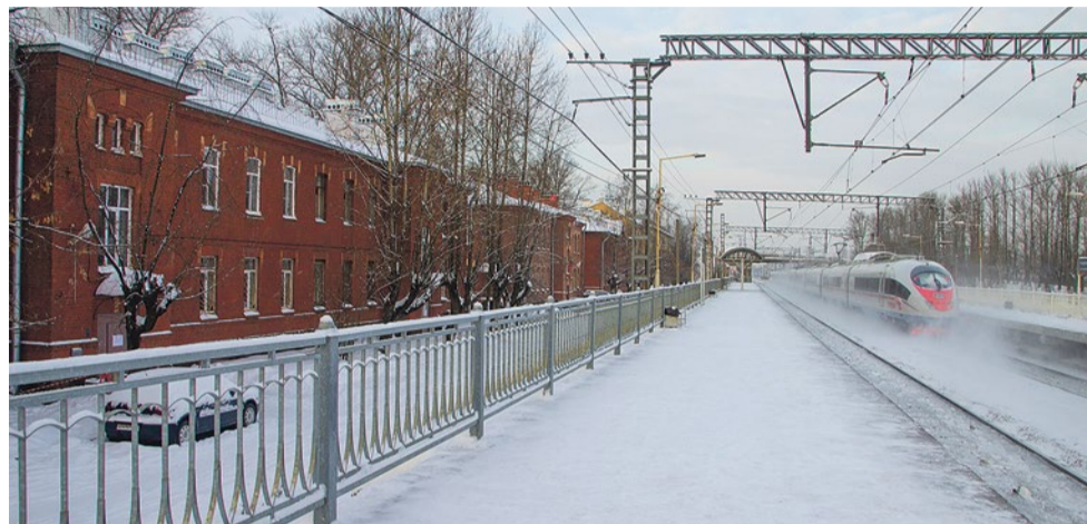
Новую магистраль хотят построить вплотную к историческим домам, а на их месте установить шумозащитные экраны
