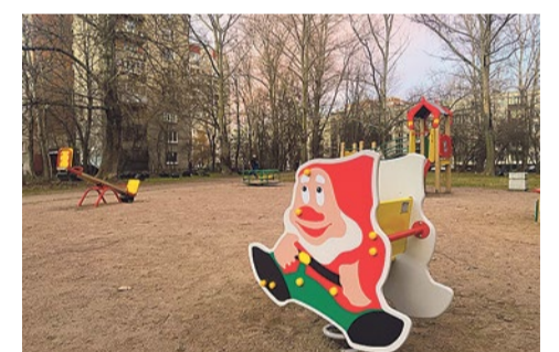
Замена игрового оборудования на Софийской улице, 39/1
