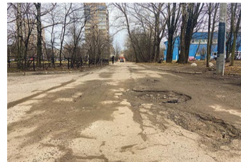
Ремонт проезда на Пражской улице, 26–34
