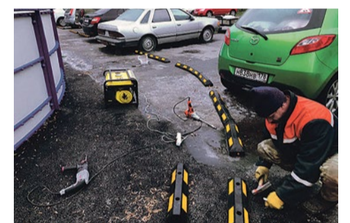
Установка колесоотбойников на Бухарестской улице, 78
